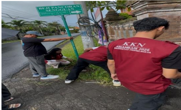
Gambar 4. Pemasangan Plang Penunjuk Arah
